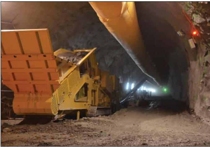
Obr. 7 Pohľad na drvič s pásovým dopravníkom umiestnený v tunelovej rúre B Fig. 7 A view of the crusher with the belt conveyor installed in tunnel tube B
