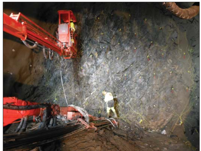
Obr. 6 Plnenie vývrtov emulznou trhavinou Fig. 6 Filling blast holes with emulsion explosive
