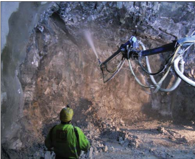
Obr. 9 Oplachnutie výrubu vodou a následné striekanie vláknobetónu Fig. 9 Sprinkling the excavation with water and subsequent application of fibre-reinforced shotcrete
