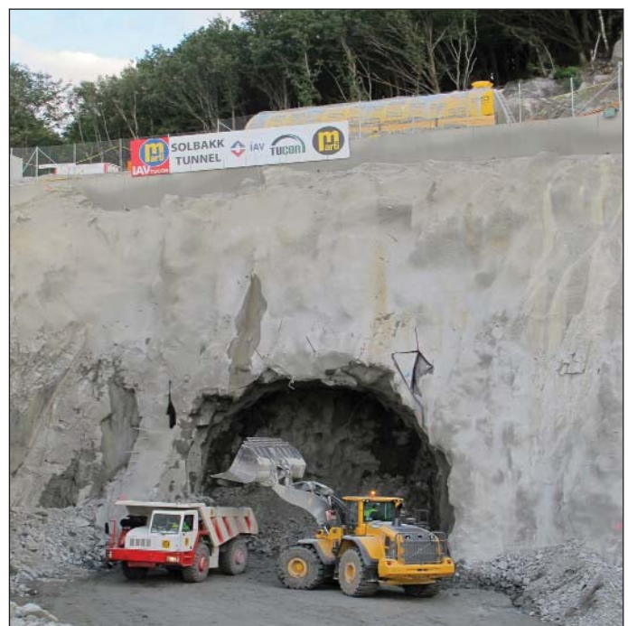
Obr. 1 Prvý záber pri začatí razenia tunela pri meste Tau
