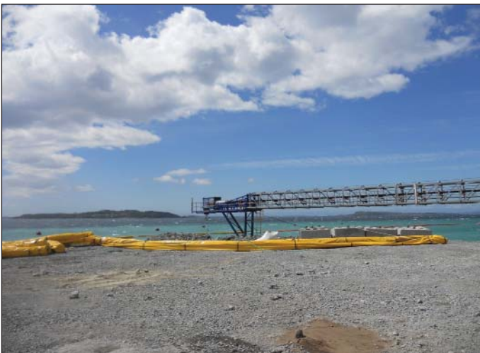
Obr. 8 Pohľad na výšpnú plávajúcu časť pásového dopravníka Fig. 8 A view of the discharging floating part of the belt conveyor
