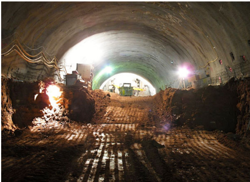
V strede lavice sa nachádza rampa v delenej čelbe
