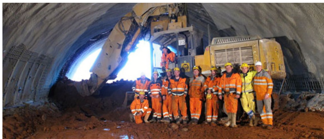
Prerazenie západnej tunelovej rúry – osádka TuCon z jednej pracovnej zmeny
