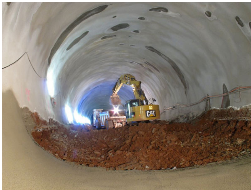
Odtážba červeného pieskovca z dna tunelovej rúry
