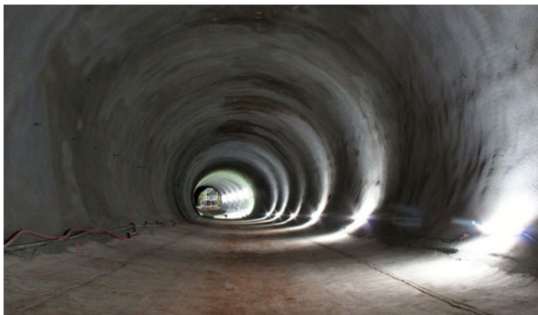
Primárne ostenie tunelovej rúry
