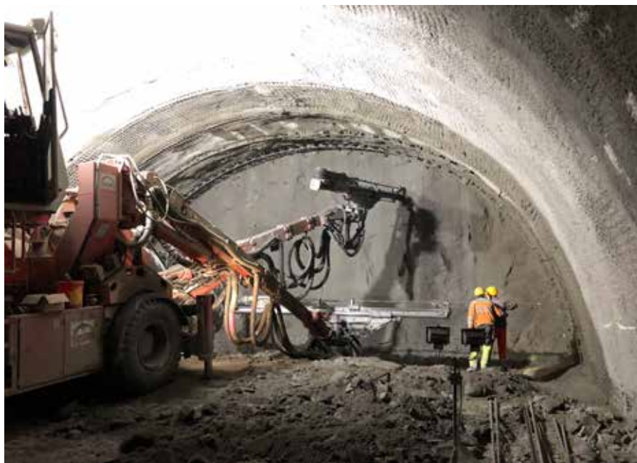
Razenie primárneho ostenia tunela Prešov
