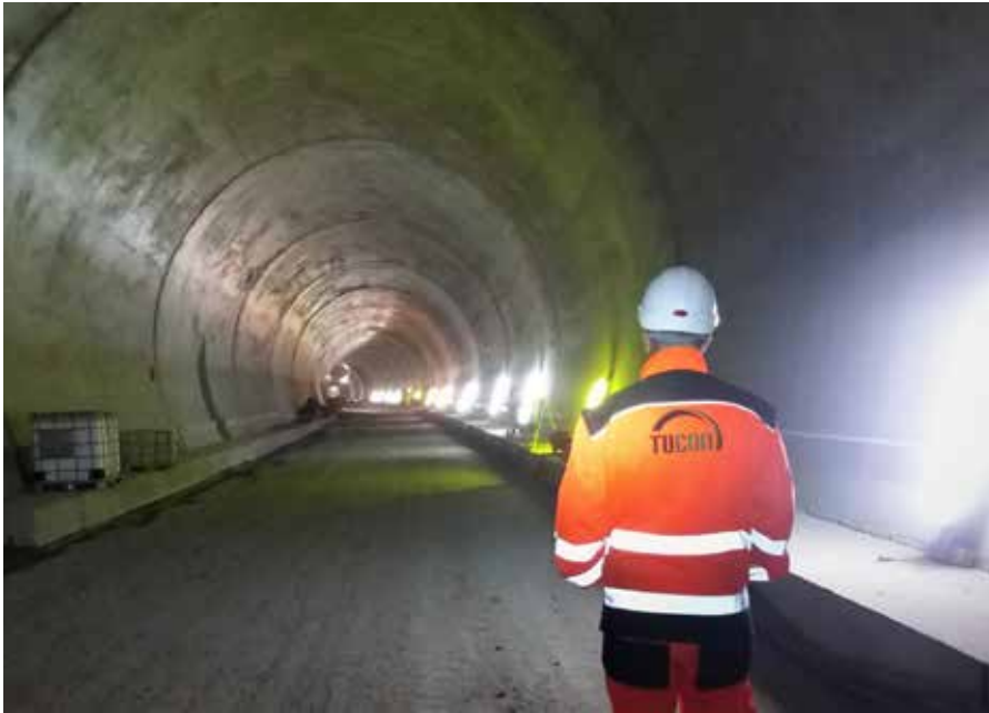
Sekundárne ostenie tunela Prešov na budovanom úseku diaľnice D1
