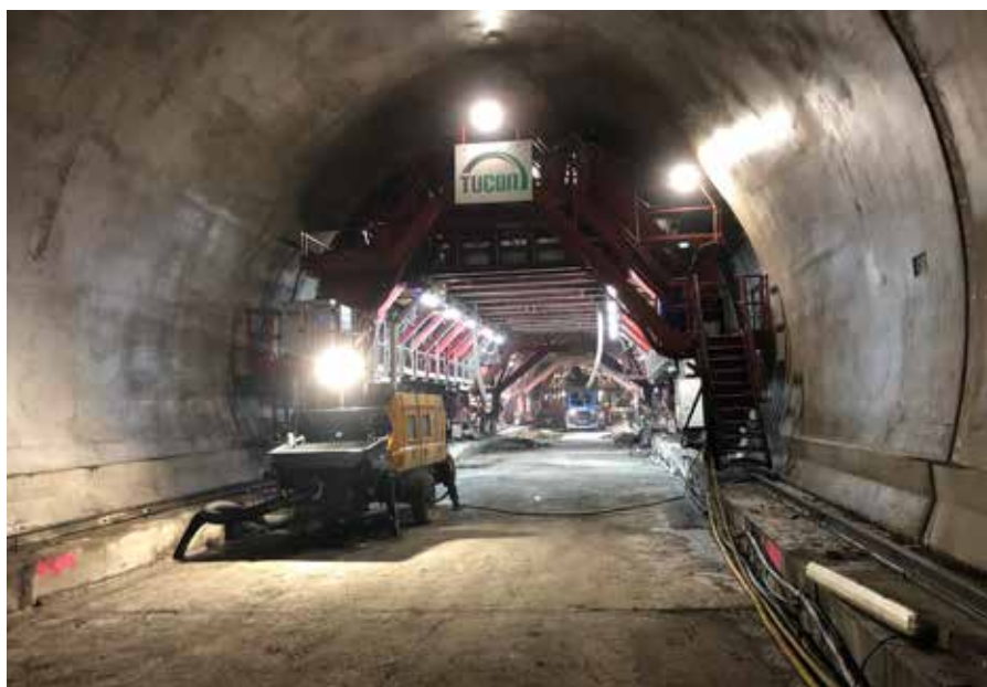
Betonáž sekundárneho ostenia
