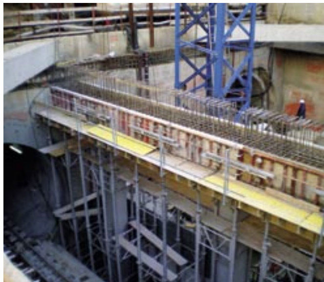
Podchytávanie stredového piliera námestia pomocou hydraulických valcov
