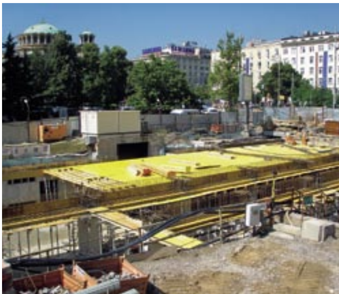
Práce na časti projektu Obnova podchodov
