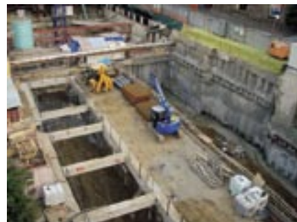
Pohľad na zónu tunelových boxov A &amp; E + B – spätný zásyp
