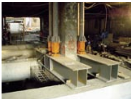
Podchytávanie stredového piliera námestia pomocou hydraulických valcov
