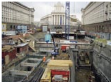
Práce na časti projektu Tunelové boxy metra
