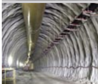
Železničný tunel Bibra, Nemecko
