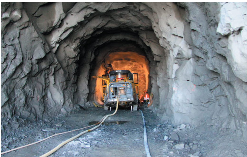
Hydroelektráreň Ilulissat, Grónsko, vrtanie čelby pred odstrelom
