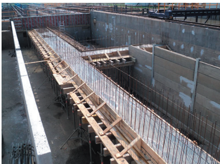
Stavba ČOV Senica, intenzifikácia a modernizácia
