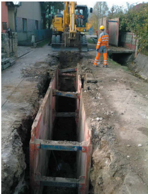
Výstavba kanalizácie v Papradňanskej doline
