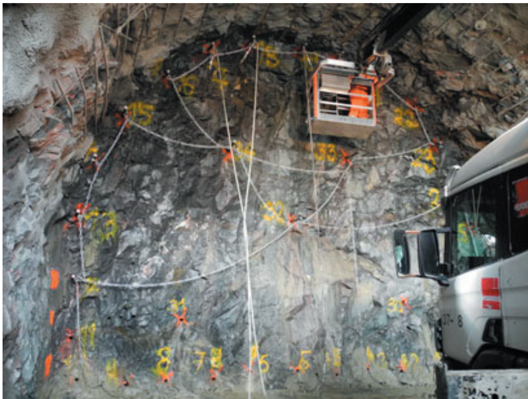
Injektáž prístupového tunela
