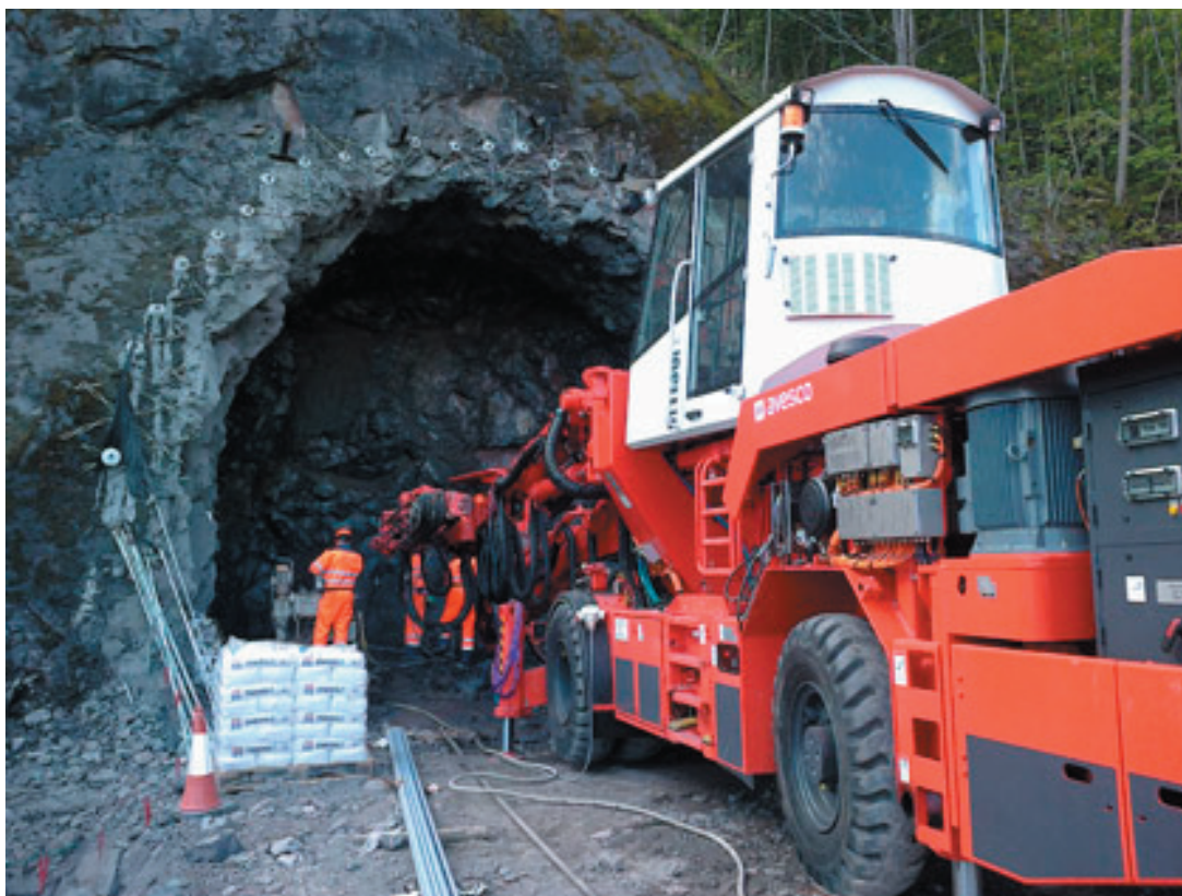
Prístupový tunel R13 – príprava na osádzanie a maltovanie kotviacich tyčí
