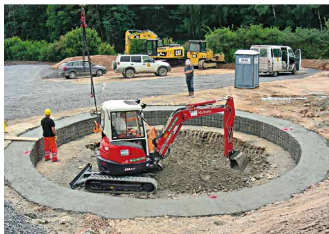
Zaústenie únikovej šachty na povrchu – tunel Rennberg
