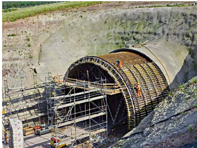
Príprava na betonáž portálového bloku – severný portál tunela Feuerfelsen
