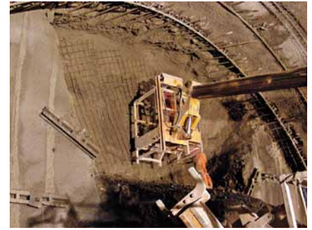
Pracovníci spoločnosti TuCon, a. s., pri zaisťovaní prvej časti výlomu kaloty (výrubová trieda 7.1A)
