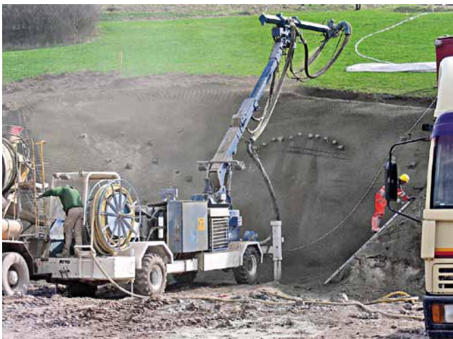
Zaisťovanie portálu únikovej štôľne striekávaným betónom a prerazenie únikovej štôľne – tunel Feuerfelsen
