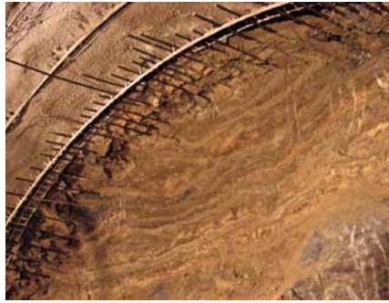
Geologická stavba čelby tunela Rennberg (4 dni pred dočasným odstavením raziacich prác)
