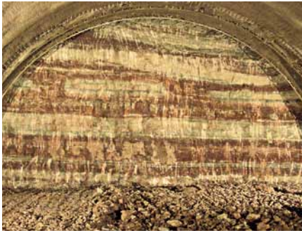
Geologická stavba čelby tunela Feuerfelsen
