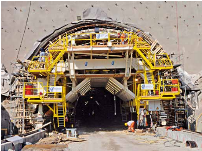
Príprava na betonáž prvého bloku klenby tunela Feuerfelsen – južný portál
