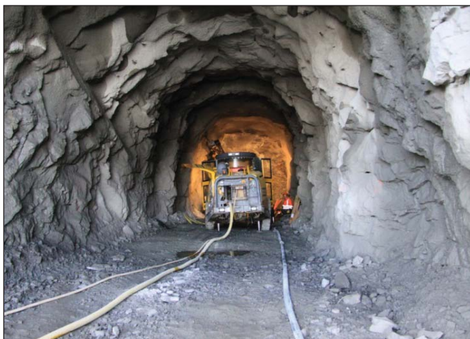
Obr. 5 Razenie odtokového tunela Fig. 5 Driving the Tailrace Tunnel
