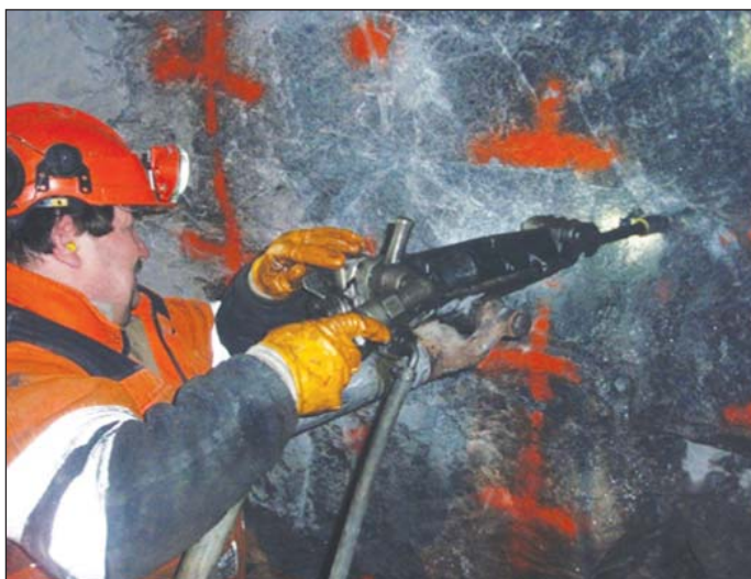
Obr. 8 Ručné vrtanie vývrtov hlavného vodného privádzača Fig. 8 Manual drilling of holes in the headrace tunnel
