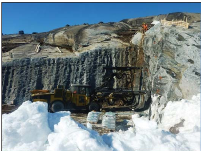
Obr. 9 Zaistovanie portálu hlavnej vpusť Fig. 9 Stabilisation of the intake 187 tunnel portal
