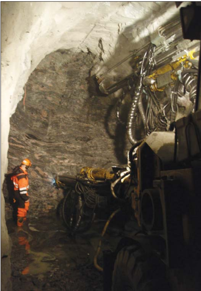
Obr. 6 Vrtanie vývrtov vo vstupnom servisnom tuneli Fig. 6 Drilling in the access tunnel
