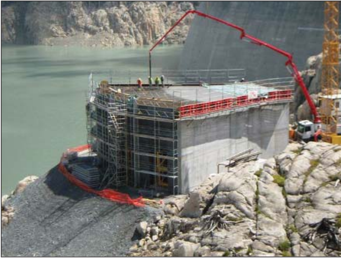
Obr. 7 Výstavba vtokovo-výtokového objektu Fig. 7 Construction of an inlet-outlet structure
