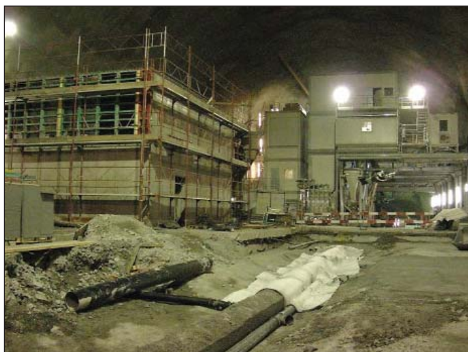
Obr. 6 Montáž technológie betonárky
