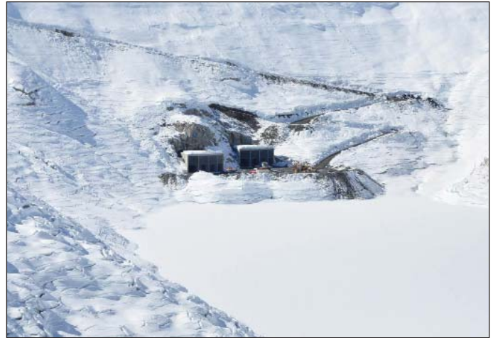
Obr. 8 Jar 2013, oba vtokovo-výtokové objekty naplavené a uložené na pripravených betónových prahoch, hladina vody v jazere Emosson je vypustená na minimum
