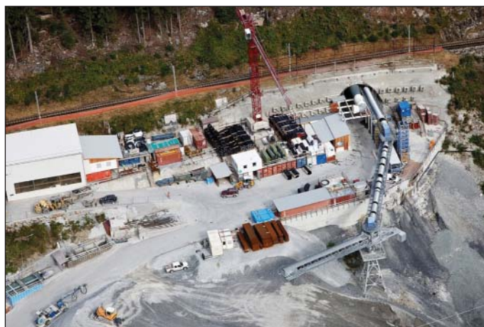
Obr. 4 Portál Le Châtelard a zariadenie staveniska, prístupový tunel ZTH razený popod železničnú trať
